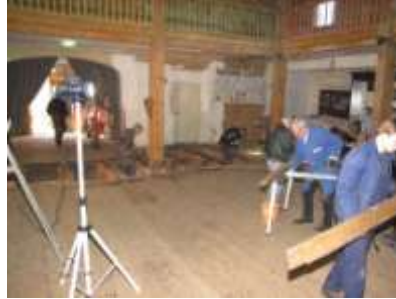
Rückbau der alten Dielen und Balken
