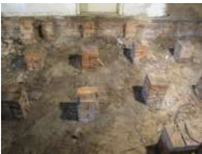
Die Ziegelfundamente von 1888 konnten repariert werden
