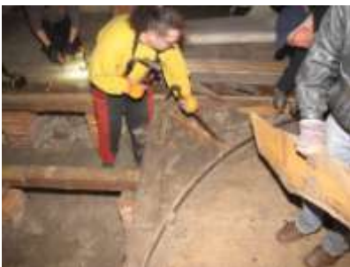
Die Zierkanten und die runde Parkettkante wurden vorsichtig ausgebaut, einige Teile können beim Einbau wiederverwendet werden.
