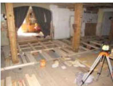
Einbau der neuen Balken für die Unterkonstruktion und die Fundamente für Rampe und Treppen
