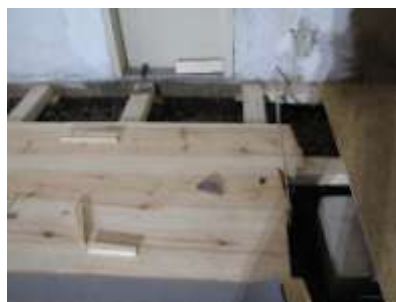
Einbau der Dielung
